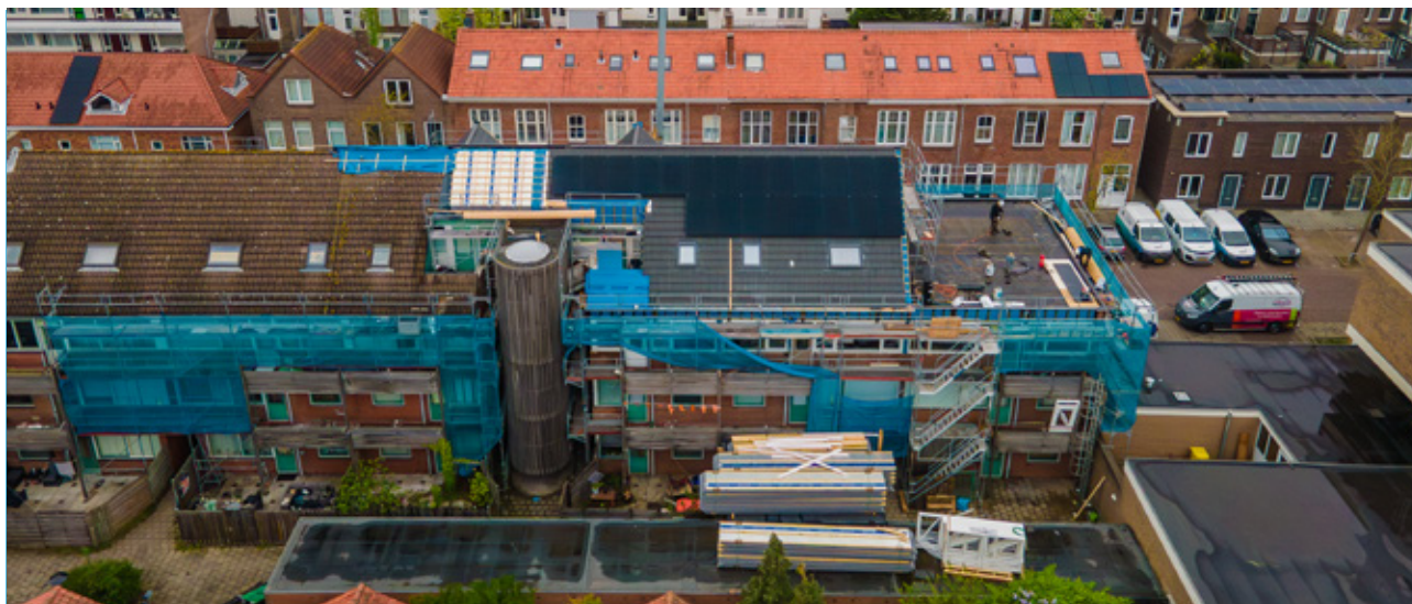
Foto: Uitvoering woningverbetering Verkuijl Quakkelaarstraat
